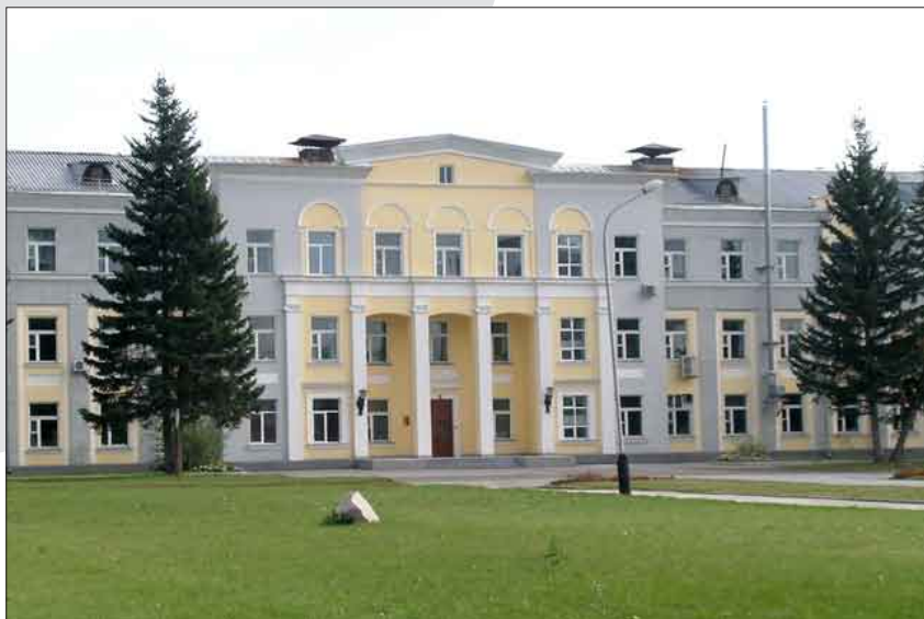
Корпус Центральной заводской лаборатории
