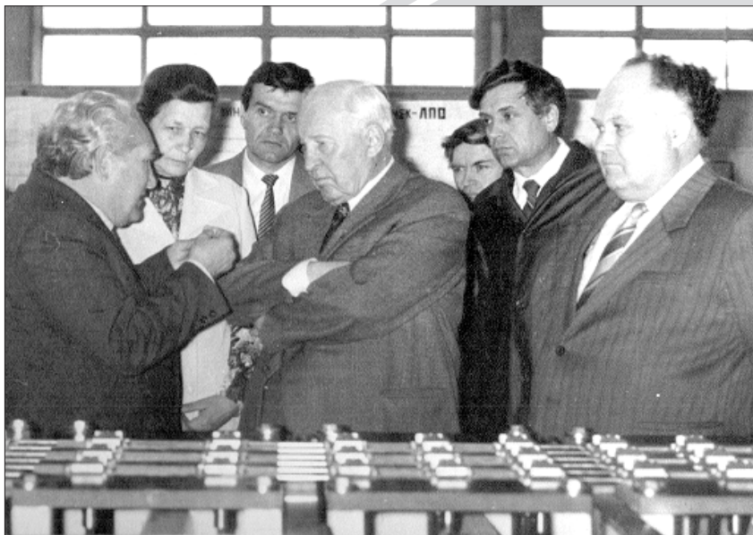
Министр среднего машиностроения Е. П. Славский лично вникал во все проблемы строительства 10-го цеха
